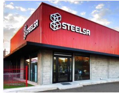
2013. Arquitectura + Construcción Steelsa. 450 m2 Hermosillo, Sonora.
