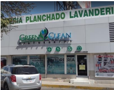
2018. Arquitectura + Construcción Green clean. 39 m2 Hermosillo, Sonora.
