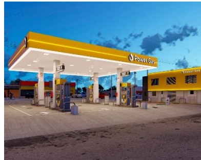
2017. Arquitectura + Construcción Gasolineras Power Gas Hermosillo, Sonora
