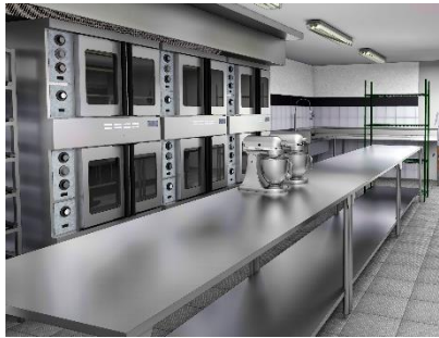
2017. Arquitectura + Construcción CEDIS Elsa Glorias. 183 m2 Hermosillo, Sonora.
