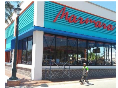
2017. Arquitectura + Construcción Marmara. 493 m2 Hermosillo, Sonora.
